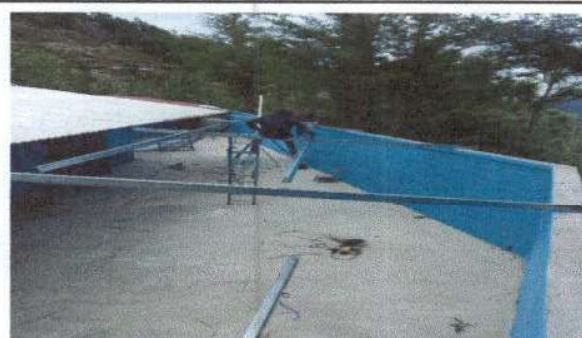
Foto 4: Sustitución de estructura de madera por metal y la lámina
