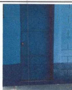
Foto 2: Sustitución de puerta de madera por metal.
