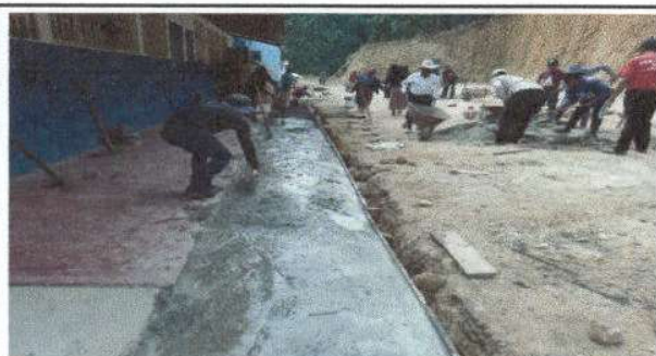
Foto 5: Sustitución de piso de torta.
